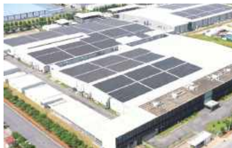
太阳能发电设备照片（YKK越南公司河南工厂）
